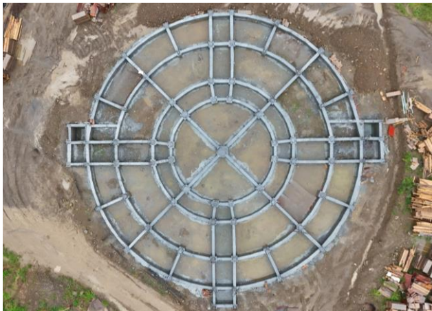
■ 大關房基礎環梁
